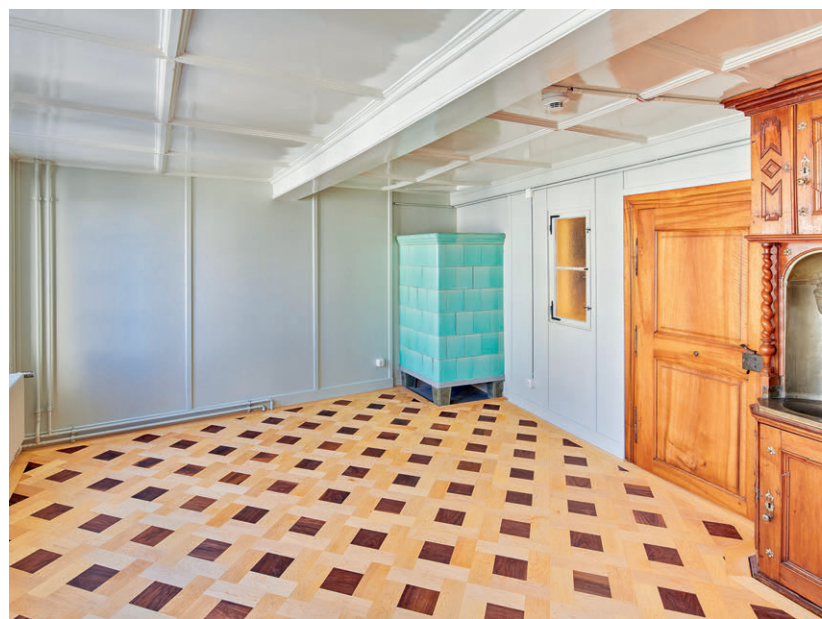
Die Böden in dem historischen Zuger Altbau wurden erneuert. Das gewählte Linoleummuster fügt sich wie selbstverständlich in die Umgebung ein und ergänzt die bestehenden Farben harmonisch.
