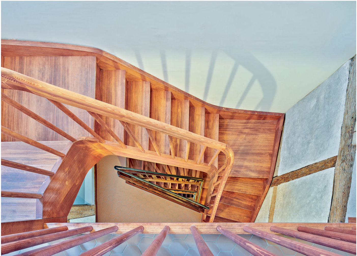
Im obersten Stockwerk wurden der Estrich und die Treppe ausgebaut. In einem warmen Branton gestrichen, verbindet Letztere die Stockwerke stilvoll miteinander.
