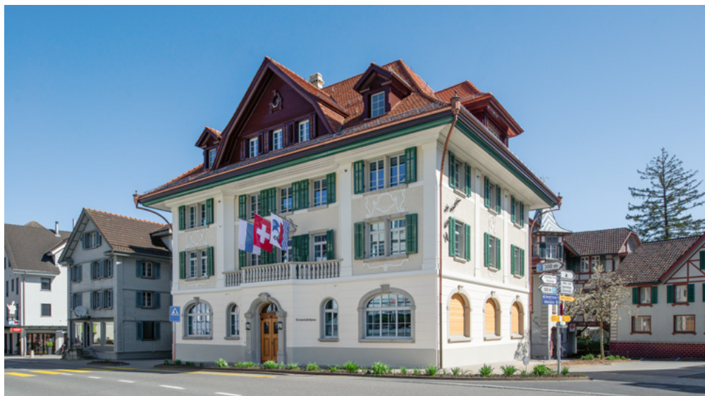
Abb. 23 Unterägeri, Seestrasse 2, Gemeindehaus. Nord- und Westfassade mit neuer Hauptingangstüre und neuen sprosierten Holzfenstern mit profilierten Kämpfern. Holzrollläden im Erdgeschoss und Textilmarkisen an der Westfassade.
