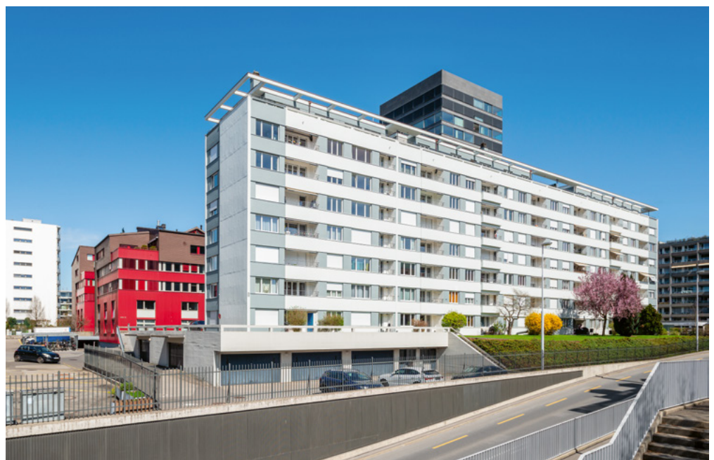
Abb. 26 Zug, Baarerstrasse 115, 117, 117a, Wohnhaus Orris. Eingezogene Loggien und vorspringende Balkone verleihen dem Baukörper Plastizität.
