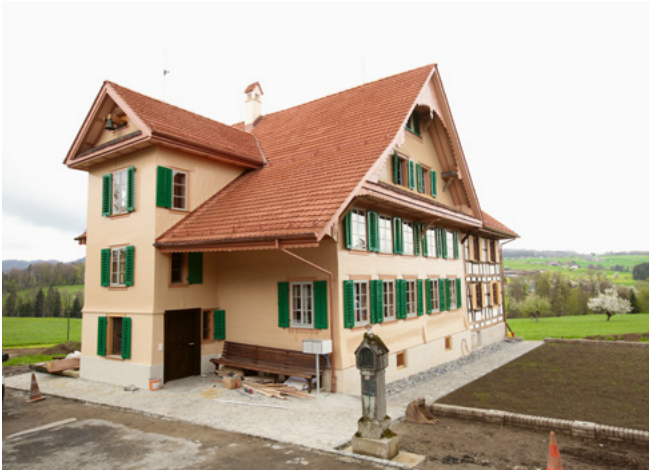
Abb. 1 Baar, Hof Deibüel. Das 2024 fertig renovierte Wohnhaus Deibüel, kurz bevor es in der Nacht vom 11. auf den 12. April 2024 durch einen Brand vollständig zerstört wurde.
