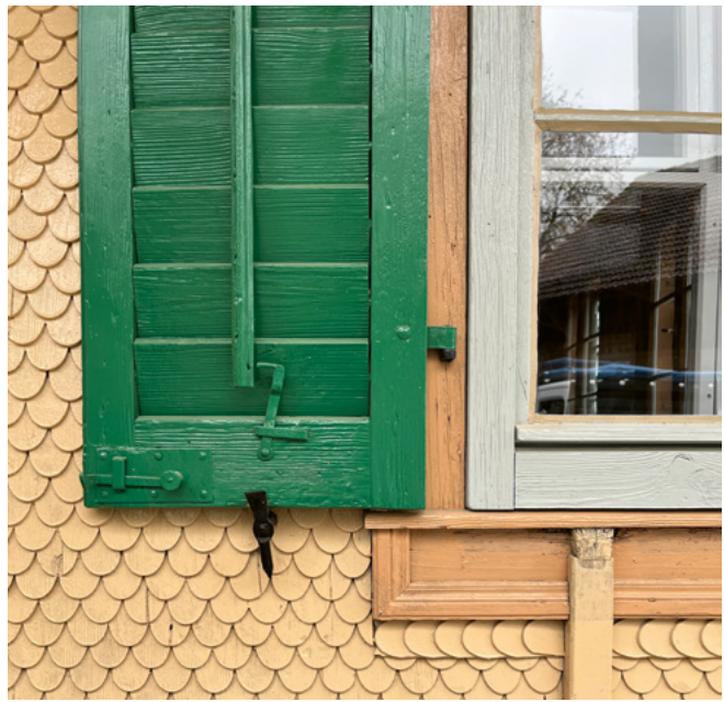
Abb. 4 Detailansicht der Südfassade mit Farbgebung von Schindeln und Holzläden nach Ergebnissen der Farbuntersuchungen.
