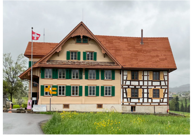
Abb. 2 Das Wohnhaus Deibüel mit Fachwerkanbau von Süden nach der Renovation.
