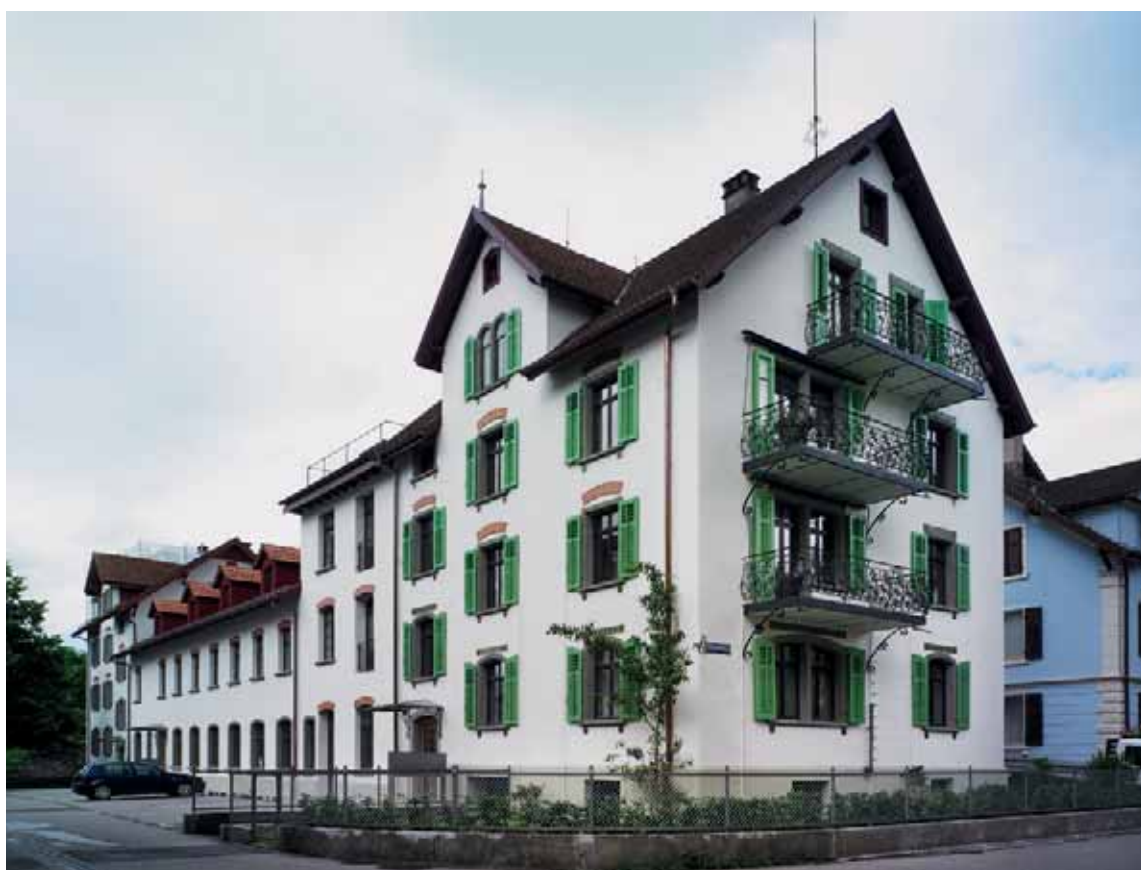
Die Liegenschaft wurde wieder zu einem ◀ Wohn- und Gewerbebau.
