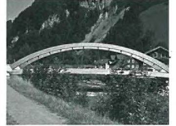
Kirchenbrücke, Muotathal Architektur: Edi Imhof
