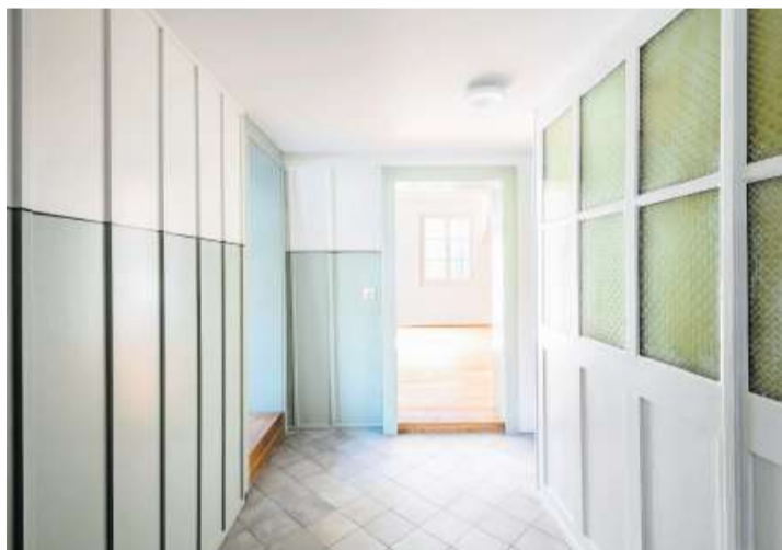
Wandtäfer und Trennwände mit geätztem Glas charakterisieren die Räume auch nach der Sanierung.
